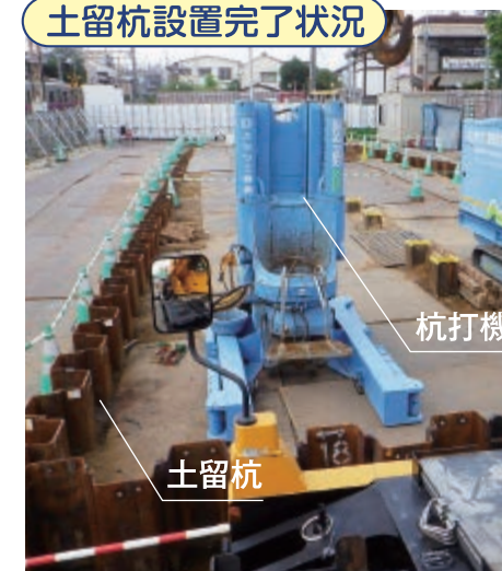
土留杭設置完了状況
