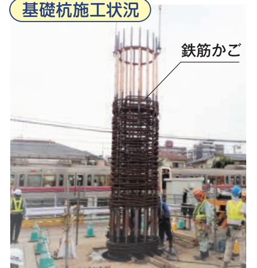
基礎杭施工状況
