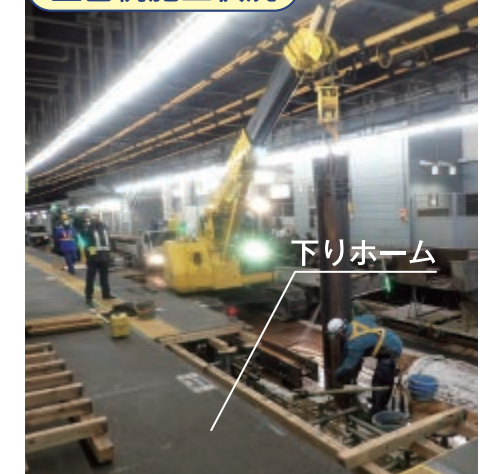
土留杭施工状況
