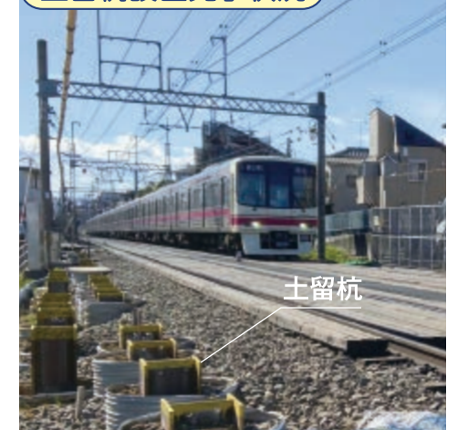
土留杭設置完了状況
